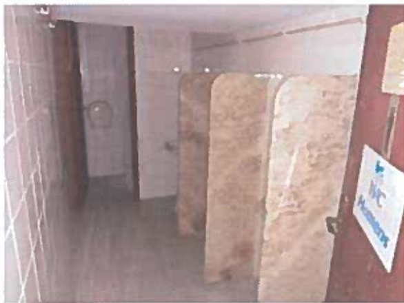
Fig 7 – Vista de WC
