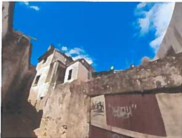
Fig 5 -Vista do prédio Art 3765 e envolvente
