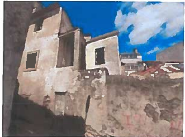
Fig 4 -Vista do prédio Art 3765 e envolvente
