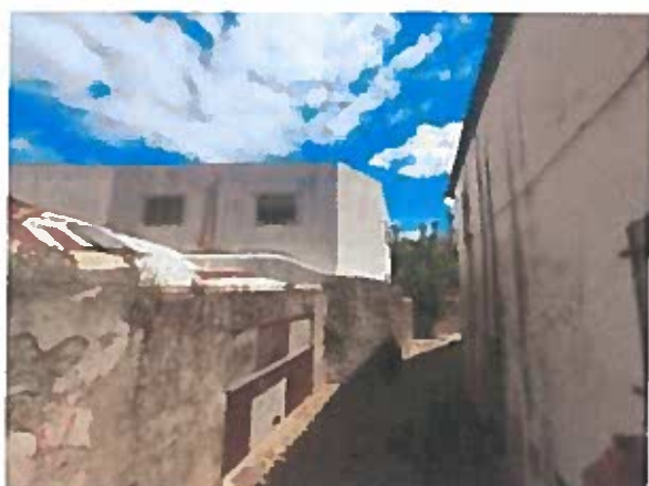
Fig13-Vista do prédio Art3765 e envolvente
