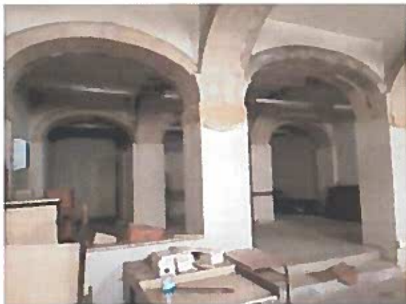
Fig 5 – Vista de Sala
