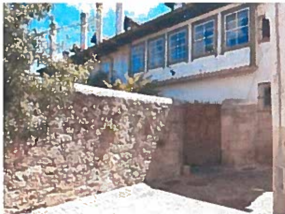
Fig 4 – Vista do prédio Art 884 e envolvente
