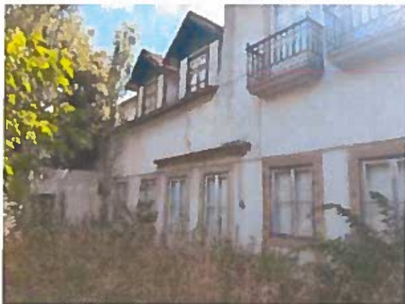
Fig 11 - Vista do prédio Art 884 e envolvente
