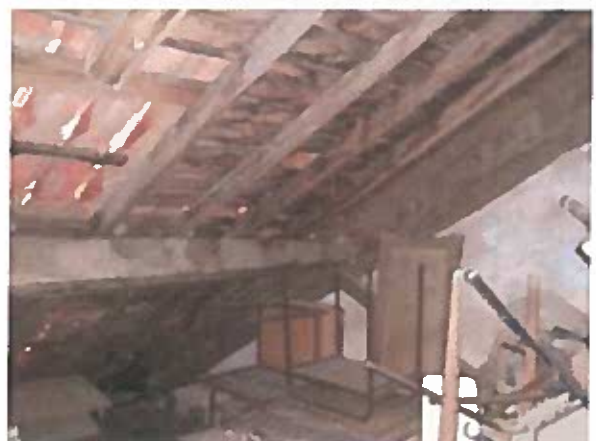
Fig 14 - Vista do Sótão
