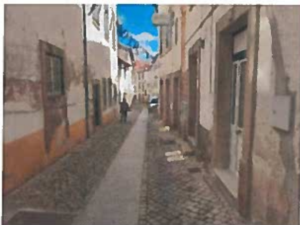
Fig 7 -Vista do prédio Art 3765 e envolvente
