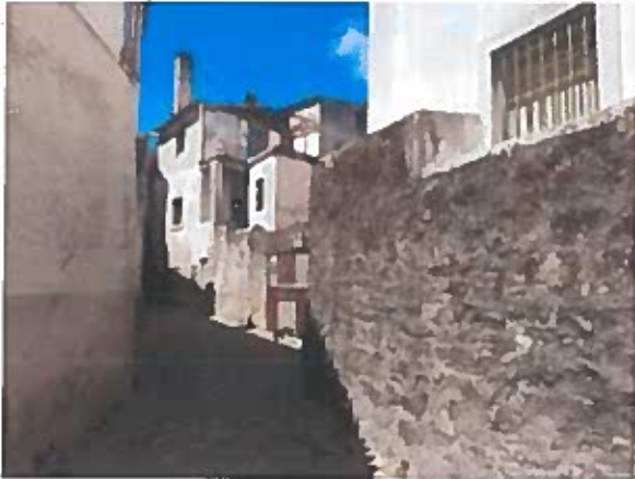
Fig 3 -Vista do prédio Art 3765 e envolvente
