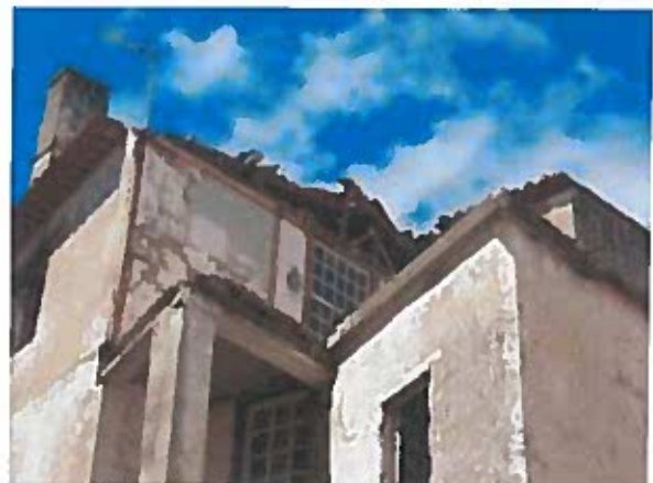
Fig 6 -Vista do prédio Art 3765 e envolvente
