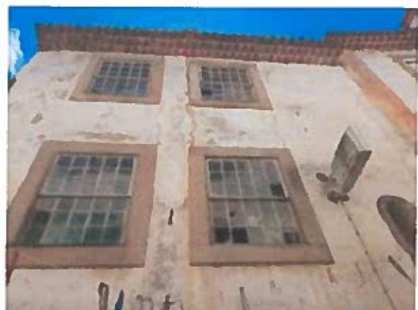
Fig 8 -Vista do prédio Art 3765 e envolvente
