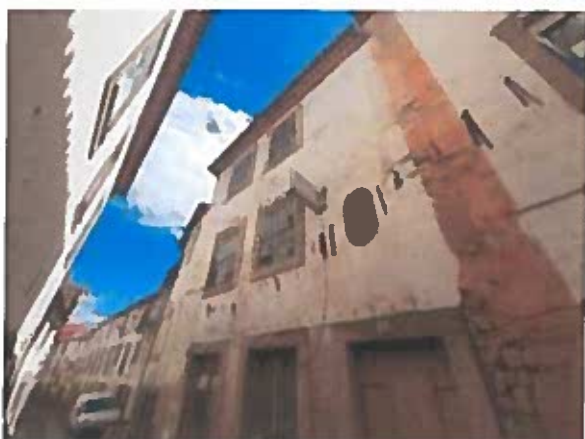
Fig11-Vista do prédio Art3765 e envolvente
