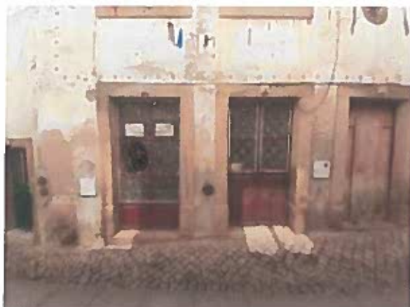
Fig 9 -Vista do prédio Art 3765 e envolvente
